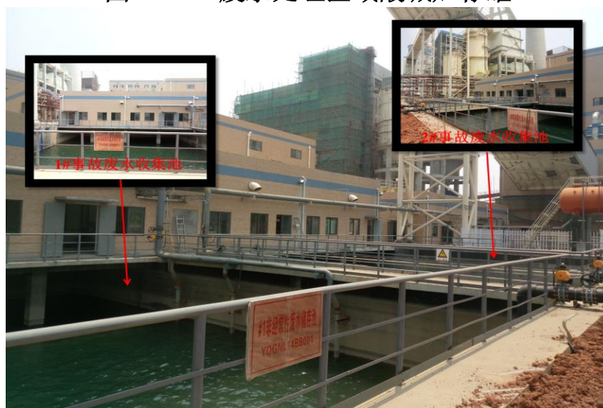
图 9-11 事故废水收集池
