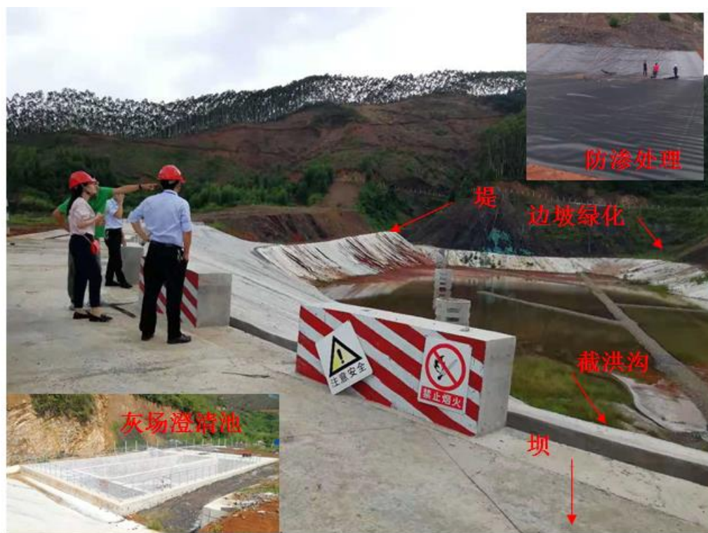
图 9-12 灰场建设情况
