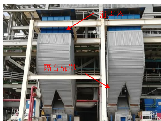
二次风机降噪措施
